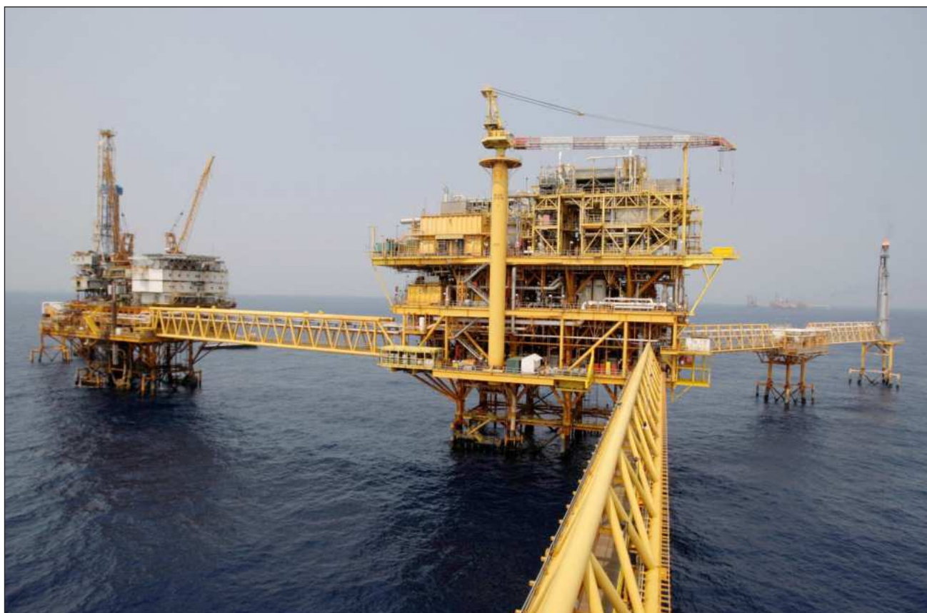
▲ De acuerdo con un comunicado difundido por Petróleos Mexicanos, se continúa con la reparación del ducto en campo Ek-Balam, luego de concluir la elaboración de envoltiente e iniciar su instalación. Foto Reuters / Archivo
