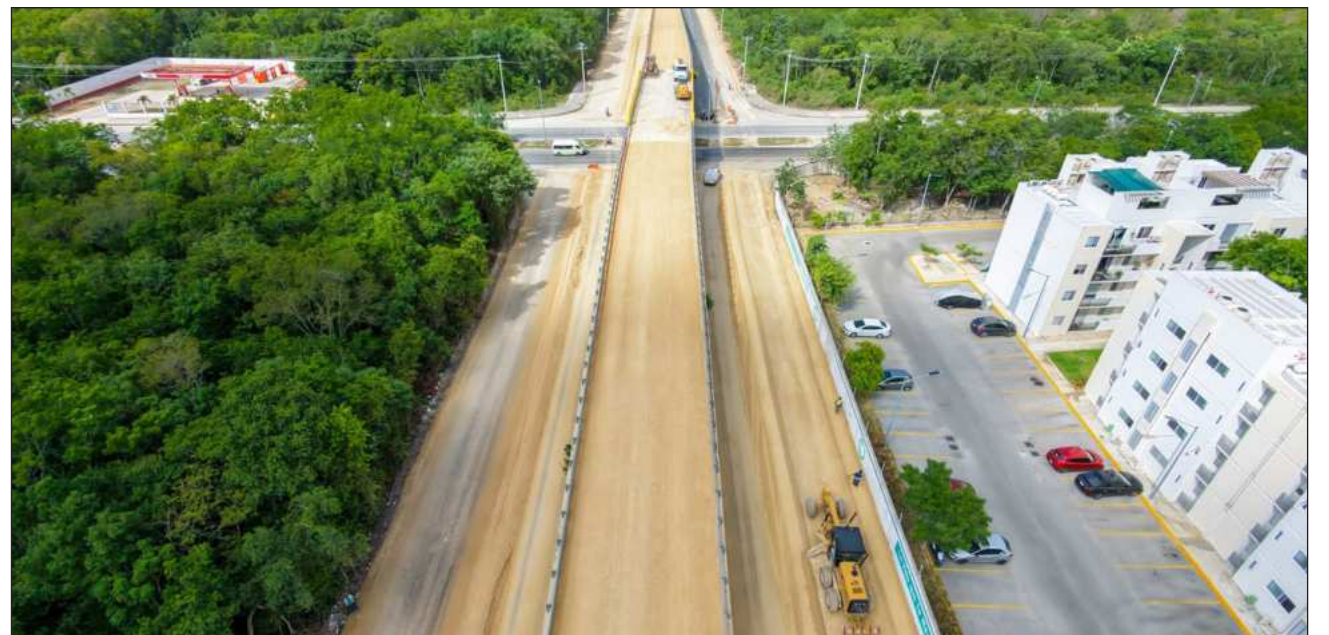
▲ La obra en el puente contempla la colocación de carpeta asfáltica de siete centímetros de espesor en las rampas de acceso y de cinco centímetros en la superestructura del puente. Foto ayuntamiento de Playa del Carmen
