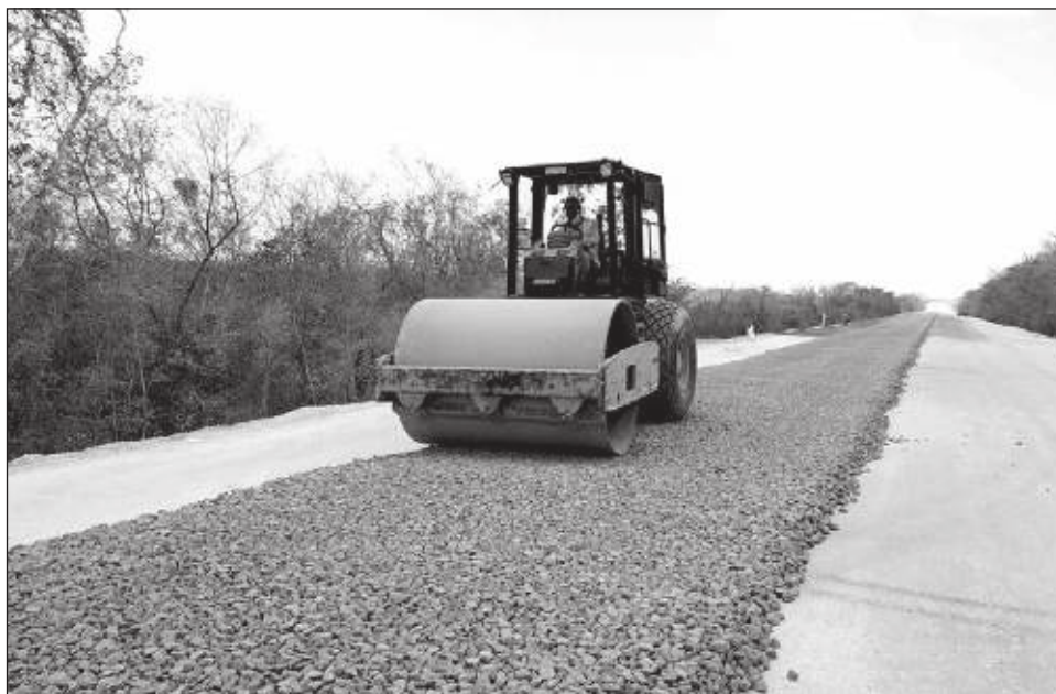
▲ El balasto es la capa de material sólido en la que se fijan los rieles. Foto Tren Maya
