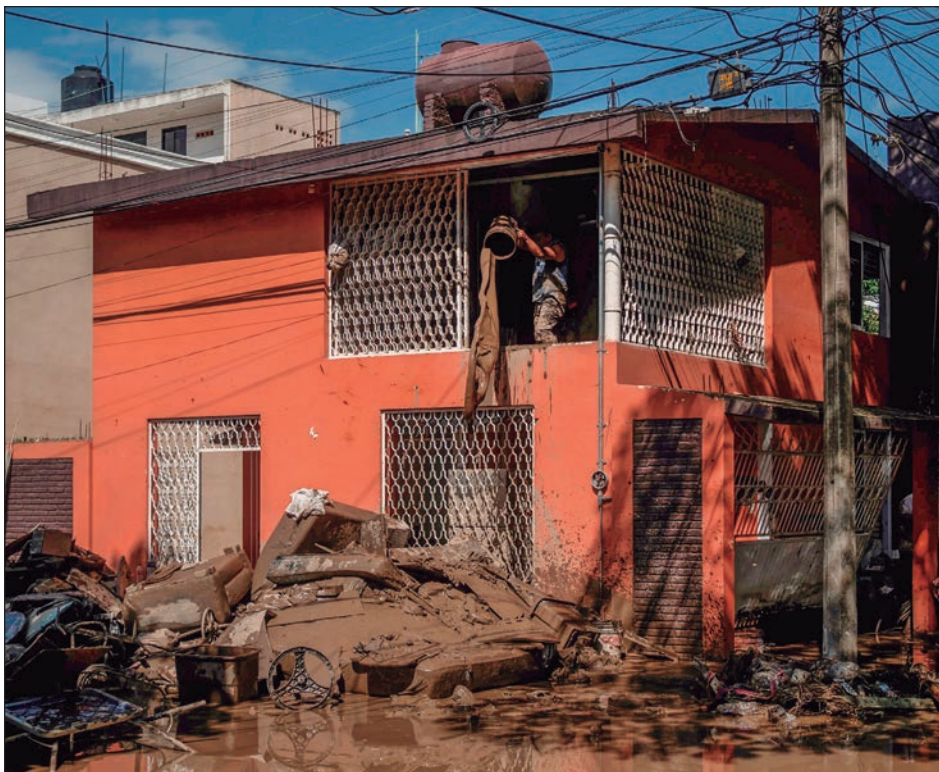
▲ El Gobierno de México censará viviendas y comercios, donde los afectados podrán detallar las pérdidas sufridas y afectaciones estructurales a los inmuebles. Foto Ap
