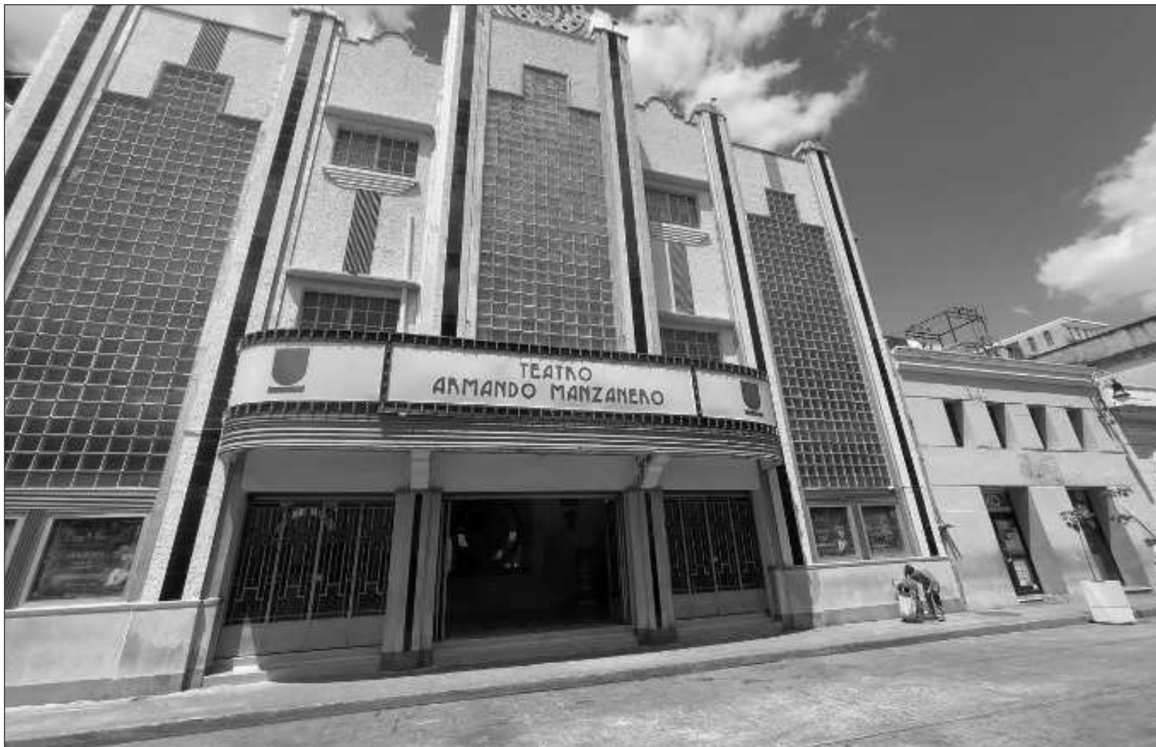
▲ En el recinto se hizo impermeabilización y mantenimiento en baños, camerinos e instalación eléctrica, pintura de la fachada y los vestíbulos, entre otras acciones. Foto jusaeri
