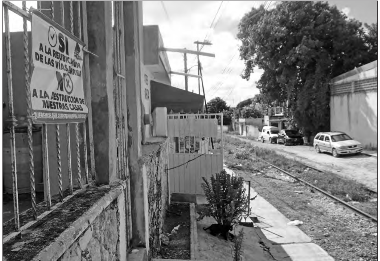
▲ La herramienta permitirá organizar los espacios de vida de las personas que habitan en 17 municipios por donde atravesará el tren. En la imagen, el Barrio de La Ermita, en Campeche, donde las casas están construidas dentro del derecho de vía. Foto Fernando Eloy
