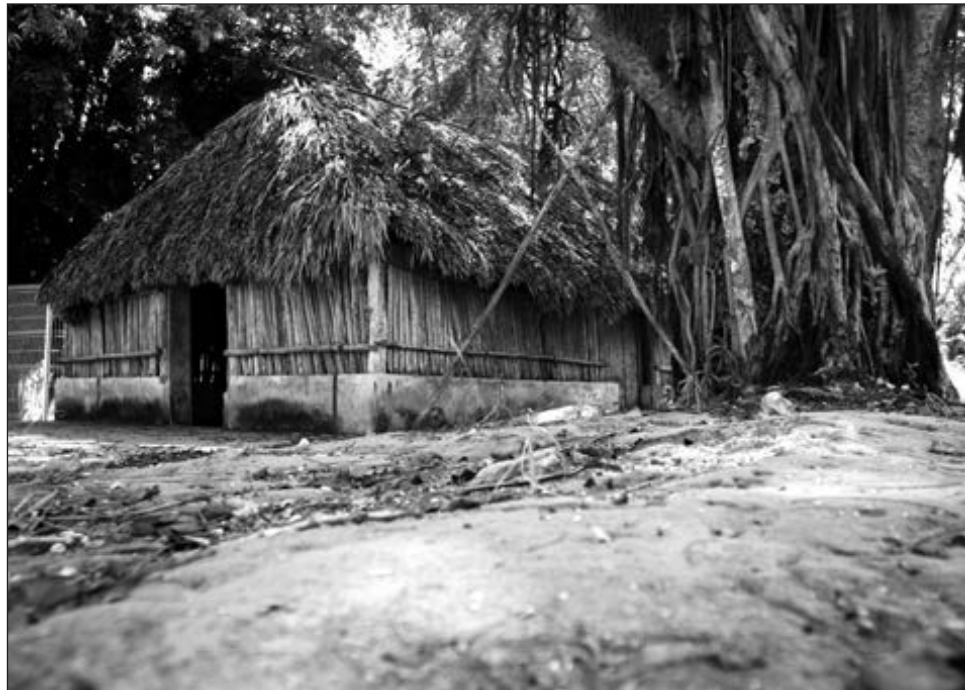
▲ En estas casas, al ser muy inclinadas, el agua resbala rápidamente, por lo que el costo de mantenimiento es mucho menor. Foto Juan Manuel Valdivia
