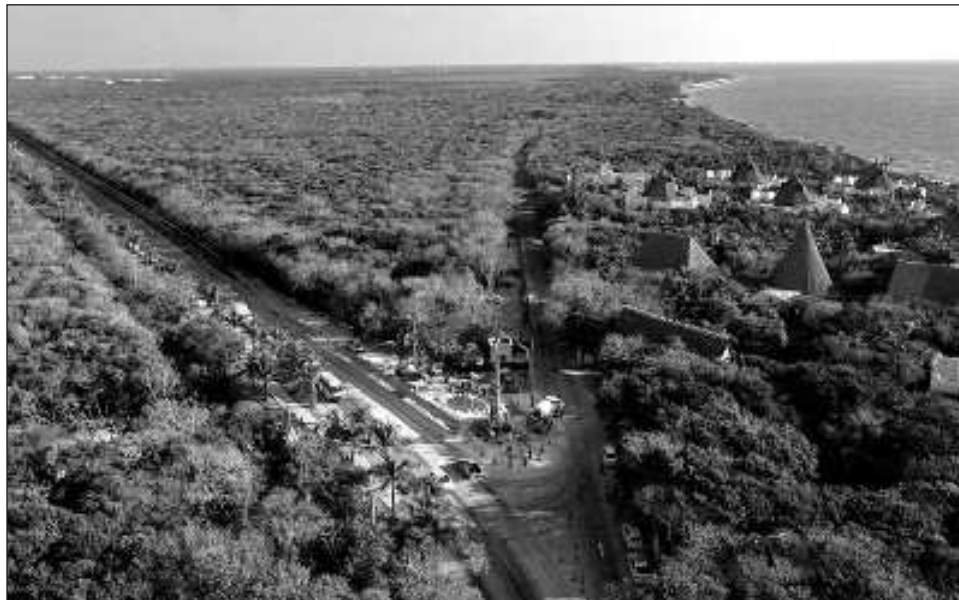
▲ “Buscamos distribuir todo en dos accesos principales: el sur (que tiene un avance de 10 por ciento en proceso de cimentación) y el acceso centro o central (ubicado en la avenida Cobá) que va a ser otro acceso principal”, destacó Román Meyer Falcón. Foto Sedatu
