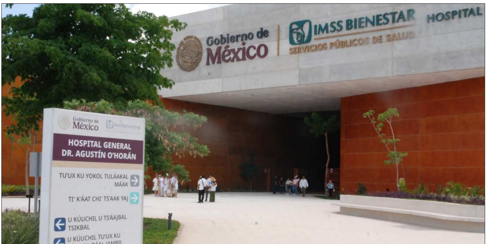
▲ Ante la detección del olor a gas, se registró de manera preventiva la evacuación de una zona del hospital para salvaguardar a pacientes y trabajadores. Foto jusaeri
