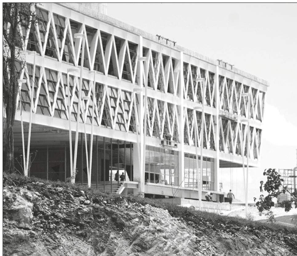
▲ Entre las inconsistencias de la obra está la falta de facilidades de acceso para personas con discapacidad. Foto Fernando Eloy
