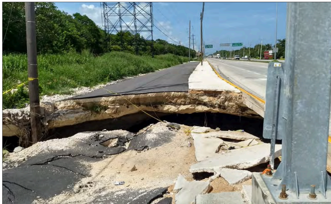
▲ El desprendimiento se originó debido a las lluvias provocadas por la tormenta tropical Cristóbal. Foto Rosario Ruiz
