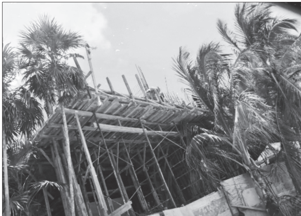
▲ Las obras comenzaron en noviembre del año pasado; es un proyecto lleno de irregularidades y que debería estar suspendido por el municipio y Profepa: Vázquez Cavedón. Foto Ana Ramírez
