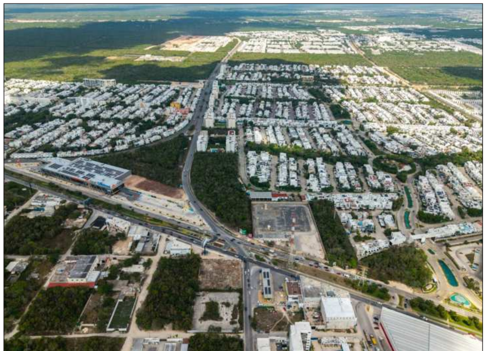
▲ El proyecto permitirá seguir mejorando significativamente la conducción de aguas residuales y seguir garantizando un servicio más eficiente y seguro para la población. Foto Aguakan
