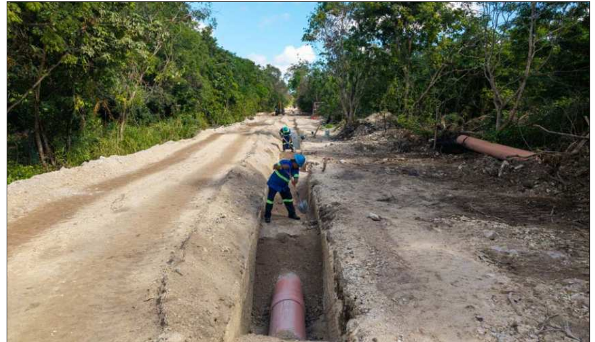
▲ Para llevar a cabo esta construcción se utiliza el método de zanja abierta, dividido en seis etapas estratégicas para reducir al mínimo las afectaciones en vialidades. Foto Aguakan
