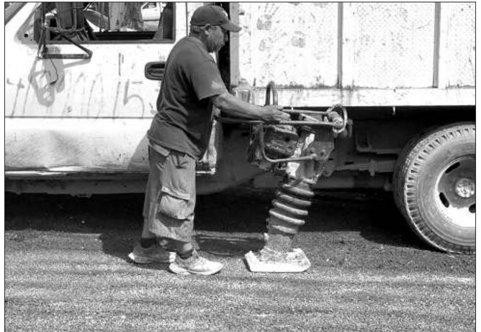
▲ La reparación forma parte de un programa de bacheo de la dirección general de Servicios Públicos que también incluye otras calles de la localidad. Foto Miguel Améndola
