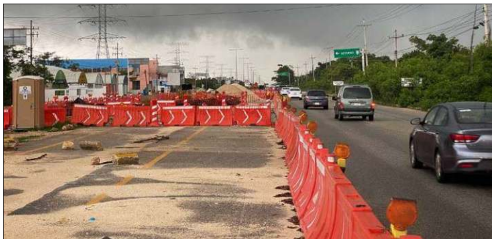
▲ “Serán 24 meses difíciles”, en los que se tratará de que la circulación vehicular no sea afectada, dijo Rogelio Jiménez Pons, director del Fonatur. Foto Juan Manuel Valdivia
