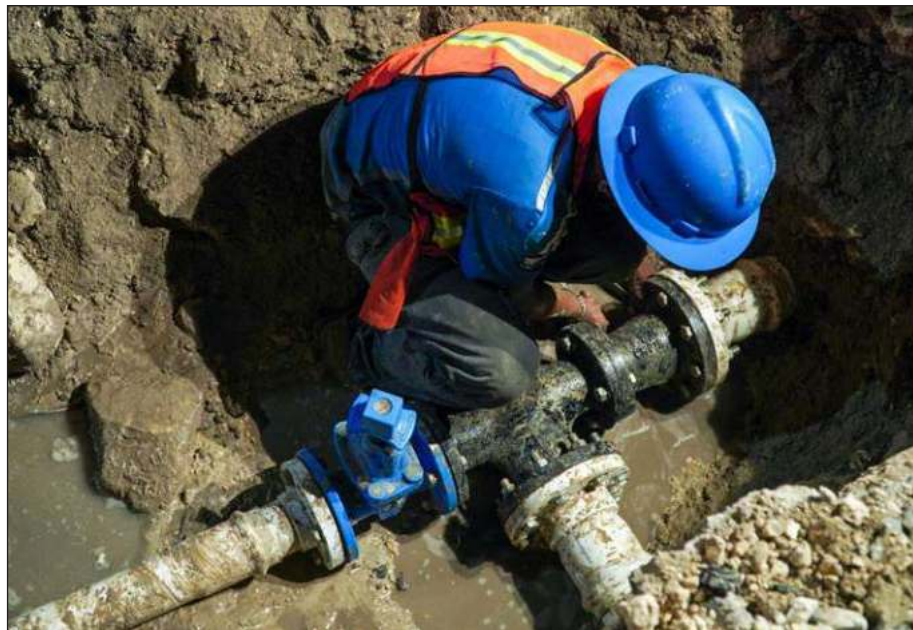
▲ La concesionaria dio inicio a trabajos de ampliación de cobertura en la red de agua potable del municipio de Puerto Morelos. Foto Aguakan
