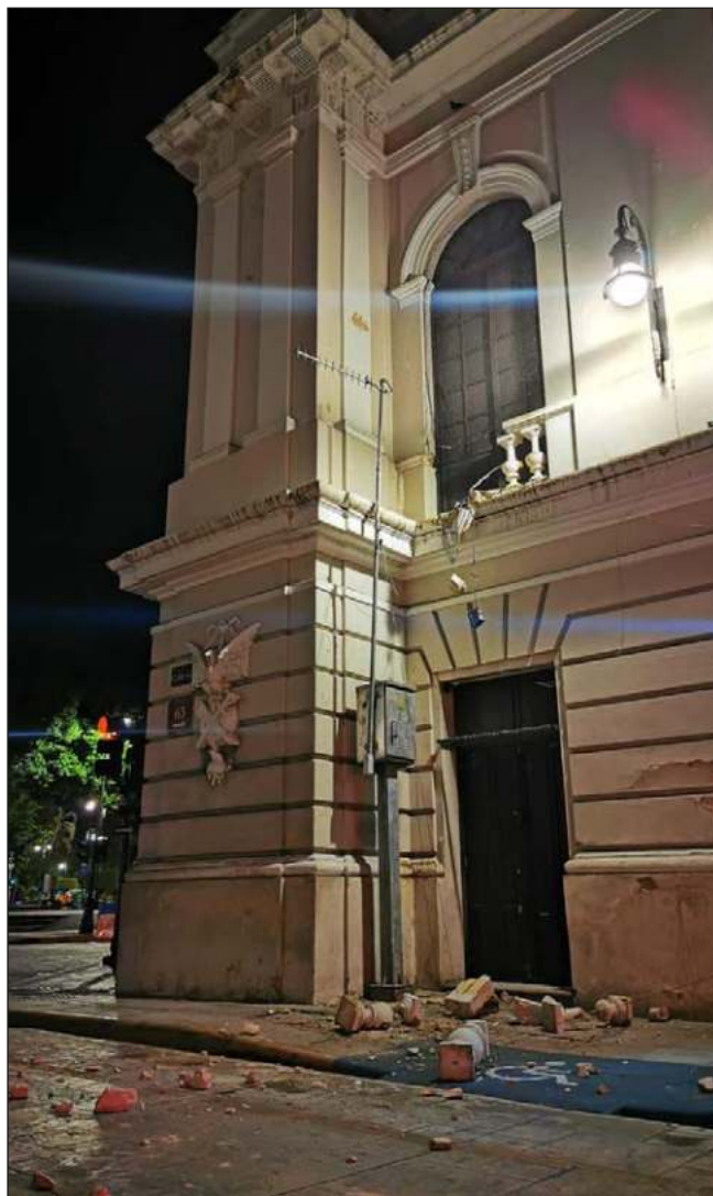
▲ El derrumbe de un balcón fue producto de la falta de mantenimiento y el exceso de humedad en el edificio. Foto cortesía INAH
