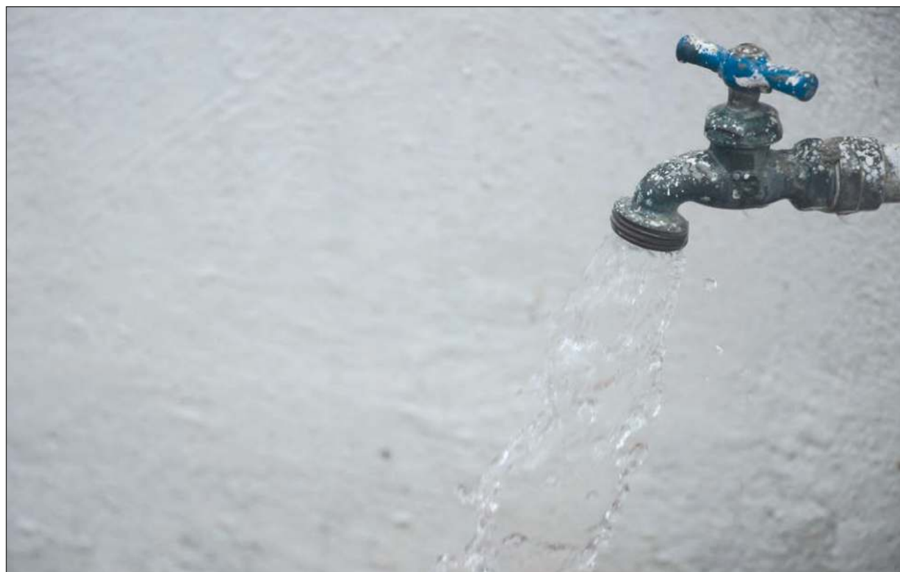
▲ De acuerdo con la JAPAY, el cárcamo de la colonia García Ginerés llevaba más de 10 años sin recibir mantenimiento y por esta causa se pierden 25 litros de agua por segundo. Foto Raúl Angulo Hernández
