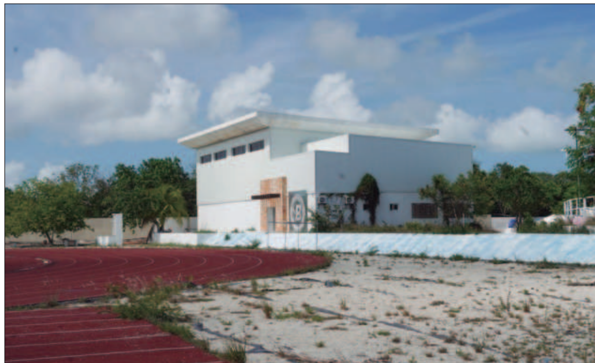
La única publicación posterior al comunicado del gobernador fue una imagen que mostraba el avance del proyecto. No hay informes públicos, sólo una obra terminada por fuera y completamente vacía por dentro. Foto Leonardo Barraza
