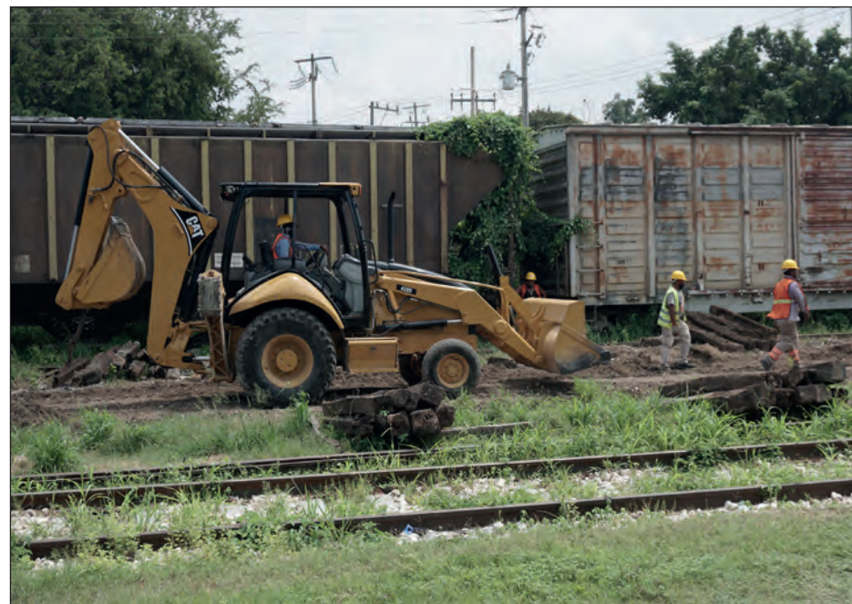
▲ El amparo concedido a las comunidades afectadas por el proyecto implica la realización de obras nuevas a lo largo del tramo 2 del Tren Maya. Foto Fernando Eloy
