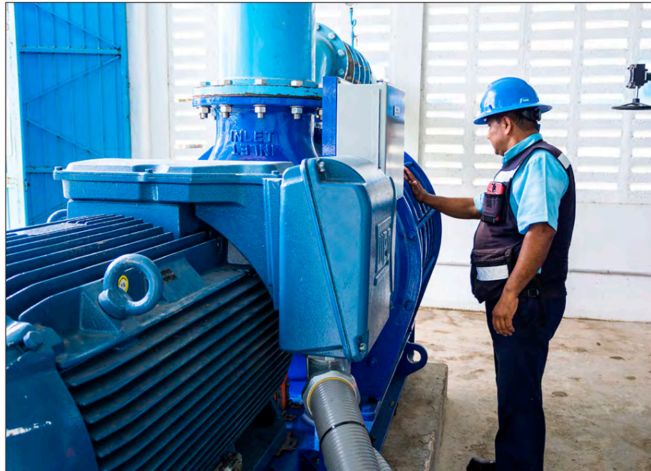
▲ La concesionaria ha trabajado en la aplicación de programas y procesos ambientales que permiten el control y la gestión oportuna de permisos ambientales. Foto Aguakan
