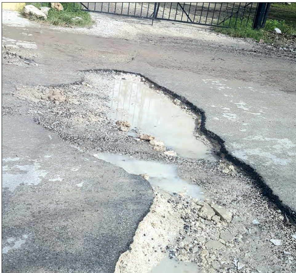
▲ En Benito Juárez, las quejas de ciudadanos en las redes sociales acusan daños a sus vehículos al circular por calles y avenidas muy afectadas. Fotos Ana Ramírez
