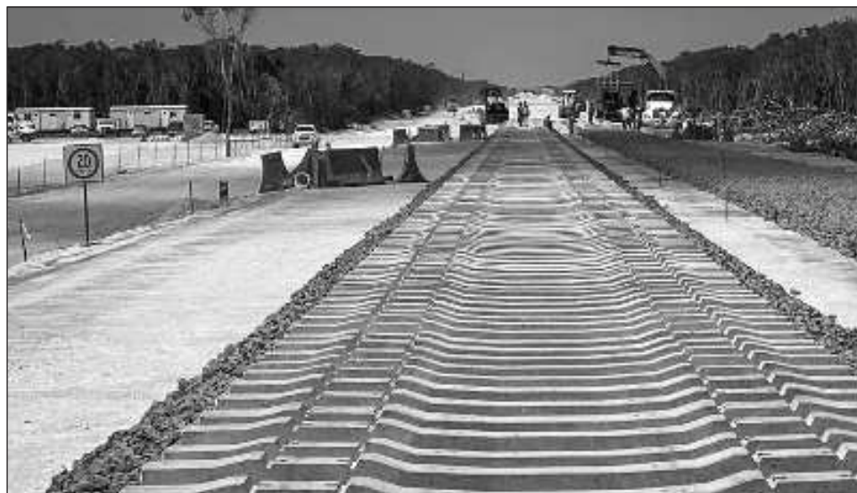
▲ El tramo 4 del Tren Maya, que va de Izamal, Yucatán, a Cancún, Quintana Roo, lleva un avance de 90 por ciento, según confirmó la empresa ICA. Foto Juan Manuel Valdivia
