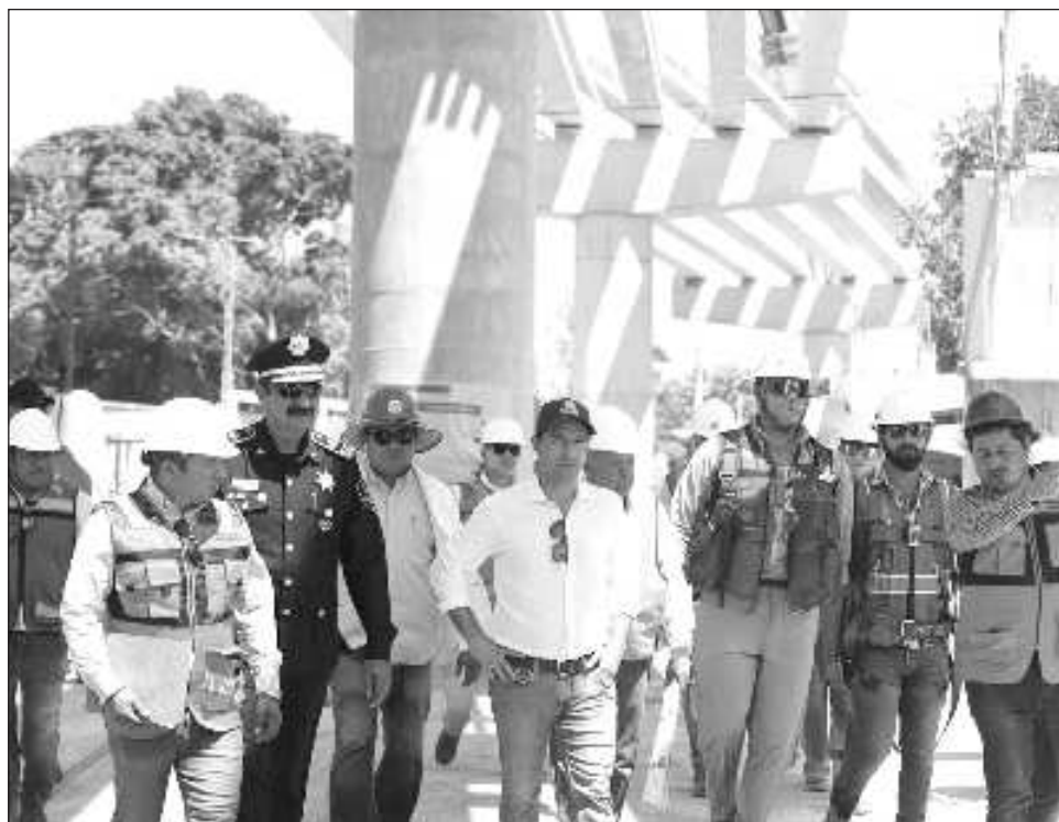
▲ El gobernador realizó un recorrido por los trabajos que se llevan a cabo sobre la calle 82 del centro de Progreso, donde atestiguó la colocación de trabes. Foto gobierno de Yucatán
