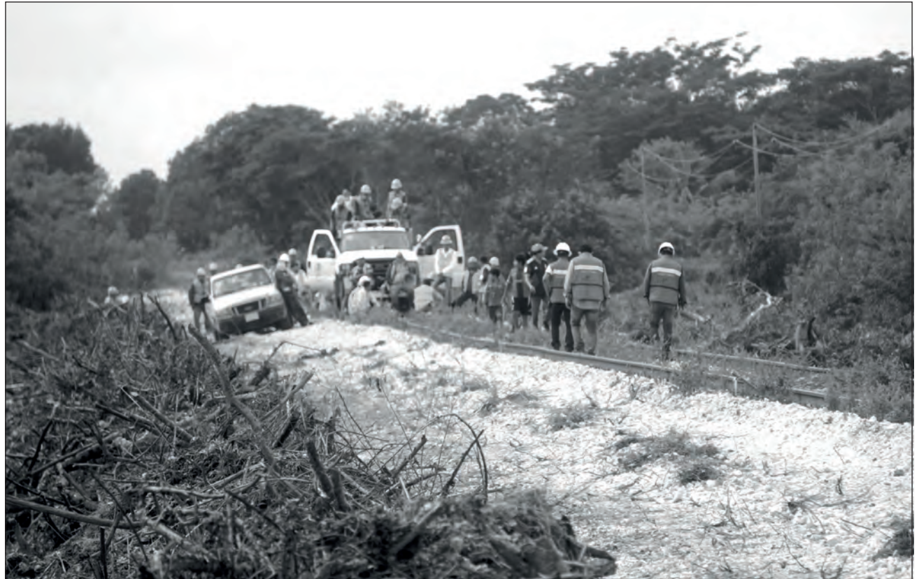
▲ La suspensión, de acuerdo con las organizaciones demandantes, impide también trabajos de la Fase 1 del Tren Maya, ya que ésta contempla obras nuevas en el tramo Escárcega-Calkiní. Foto Fernando Eloy
