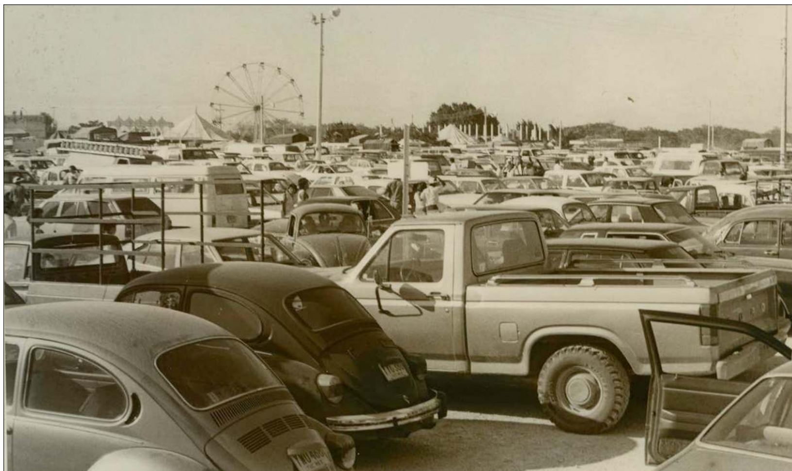
▲ La Feria Yucatan Xmatkuil inició con una extensión de 10 hectáreas. Las empresas involucradas en ese primer año fueron Coca-Cola y Dondé, las cuales hicieron una inversión de 5.6 millones de pesos. Para la construcción del espacio se pavimentaron calles, se colocó sistema eléctrico y también de agua potable. Fotos CAIHLY/Sedeculta. Curaduría: María Fernanda Heredia Zaldívar y María Fernanda García de la Cadena
