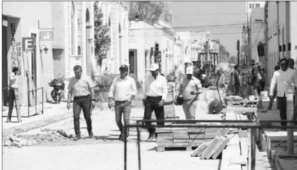
▲ El gobernador constató el estado de las obras que se realizan en la calle 47 con 60, pasando por el parque de Santa Ana hasta llegar a la zona del remate de Paseo de Montejo. Foto gobierno de Yucatán
