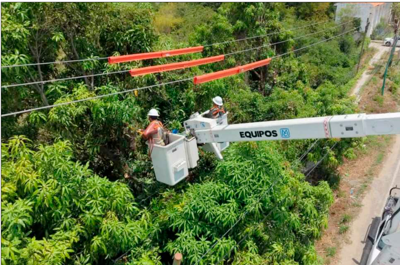
▲ La Comisión Federal de Electricidad lleva a cabo un trabajo integral de mantenimiento de las líneas que incluyen los cambios de postes, transformadores, cable, así como la calibración del tendido eléctrico. Foto FB CFE Nacional
