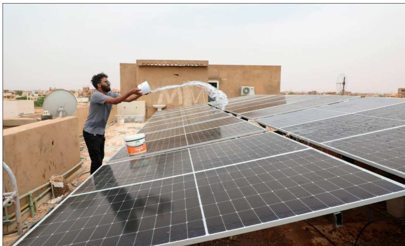
▲ En los últimos meses, se han multiplicado en la capital las vallas publicitarias que anuncian paneles solares y baterías, a medida que más sudaneses consideran pasarse a la energía solar; es “una forma de adaptarnos a esta situación”, explicó Al-Mansour. Foto Ap
