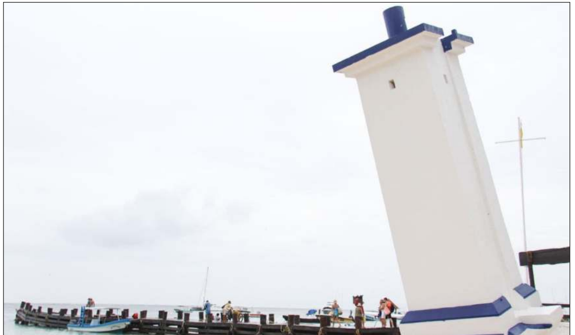
Una brigada de Servicios Públicos realizó los trabajos de raspado y pintado del faro. Foto ayuntamiento Puerto Morelos
