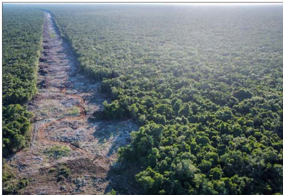
▲ El presidente Andrés Manuel López Obrador anunció que construirán un puente atirantado de 80 metros para brincar una cueva localizada en el tramo. Foto Juan Manuel Valdivia
