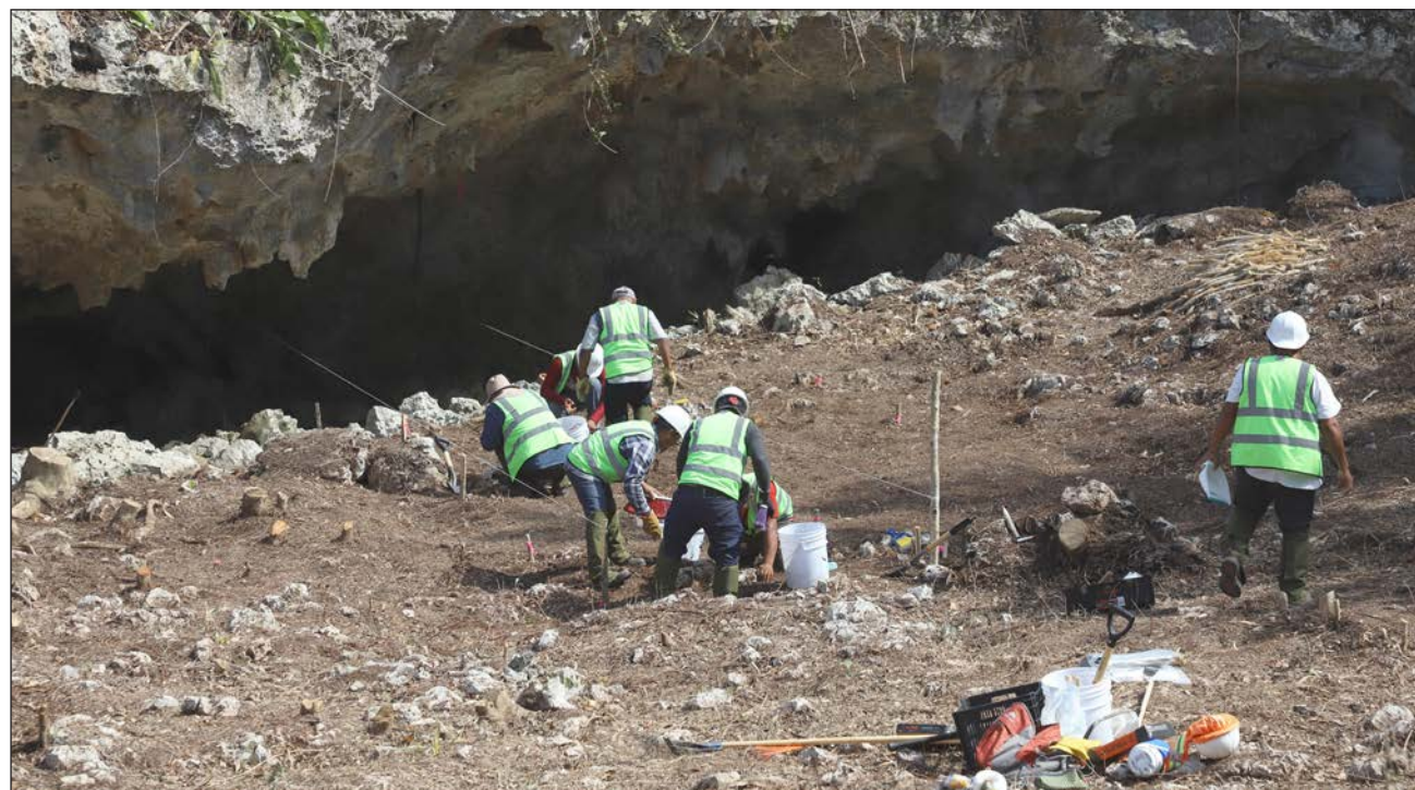
▲ Otras de las peticiones al gobierno federal es que se realicen los estudios necesarios para evitar daños a las cavernas y se transparente la información del proyecto y de los estudios. Foto Juan Manuel Valdivia
