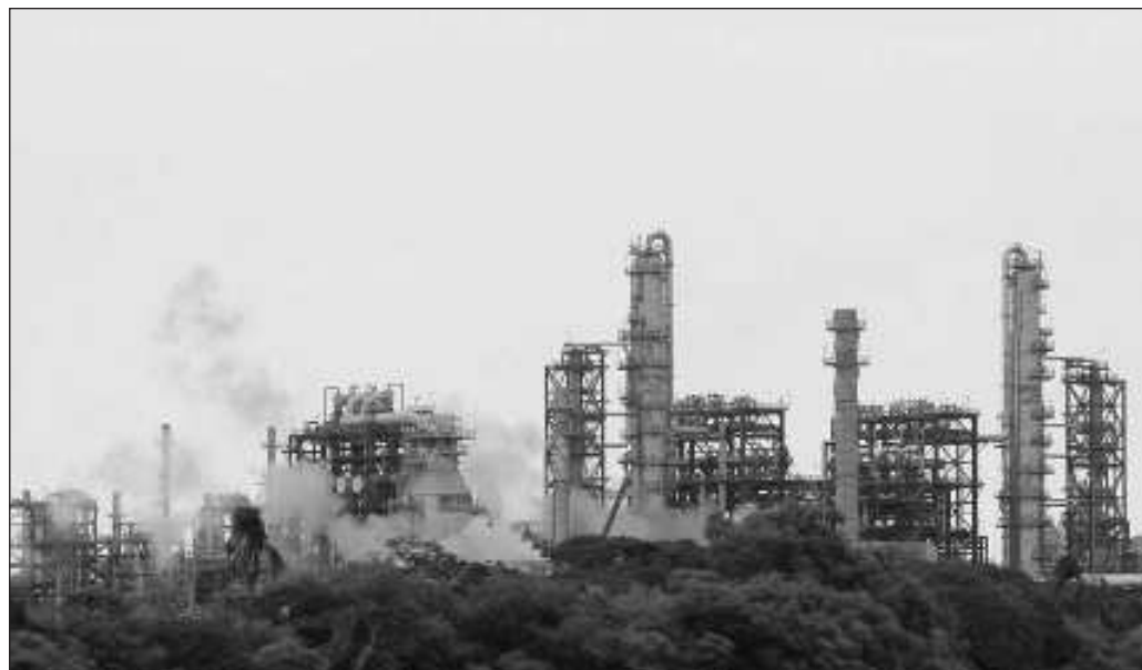
▲ La refinera apenas arranca y su producción es todavía mínima, pero seguramente veremos que a mediano plazo podría destinar al mercado internacional una buena parte de los combustibles producidos. Foto Reuters
