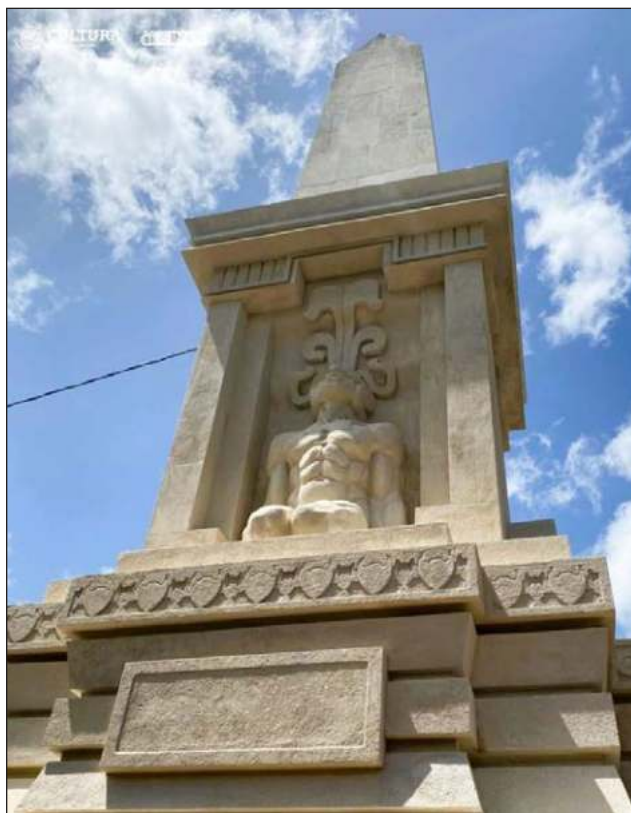
▲ Luego de finalizar todos los procesos de limpieza, se trabajó en el fijado superficial del material pétreo, en la recuperación de juntas constructivas y en la aplicación de recubrimientos de protección. Foto INAH
