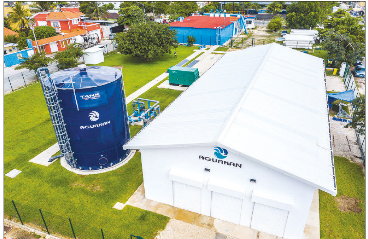
▲ En 2021, Aguakan realizará una inversión superior a los 80 millones de pesos para obras de infraestructura en mejora de los servicios de agua potable, alcantarillado y saneamiento en todo el municipio. Foto Aguakan
