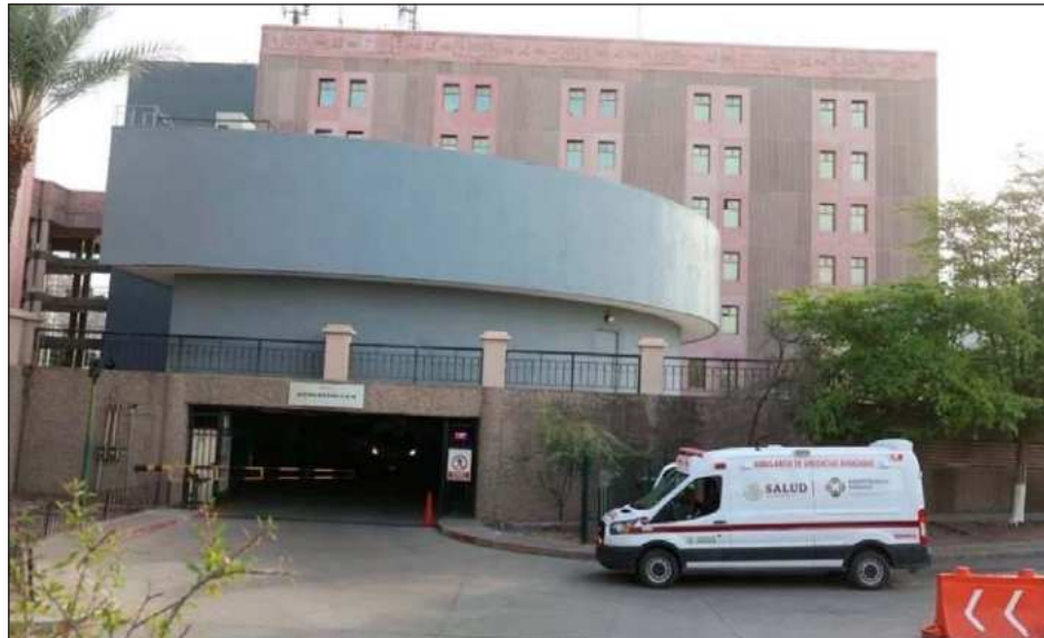
▲ Como medida preventiva, trabajadores del edificio fueron desalojados. Foto Cristina Gómez
