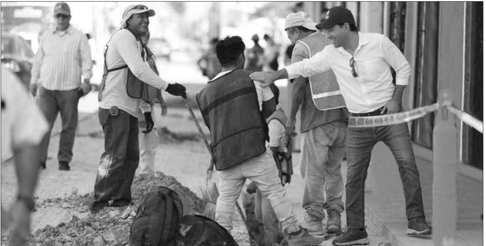
▲ Mauricio Vila Dosal recorrió el tramo de la obra que comprende desde la zona de remate de Paseo de Montejo hasta Palacio de Gobierno. Foto gobierno de Yucatán
