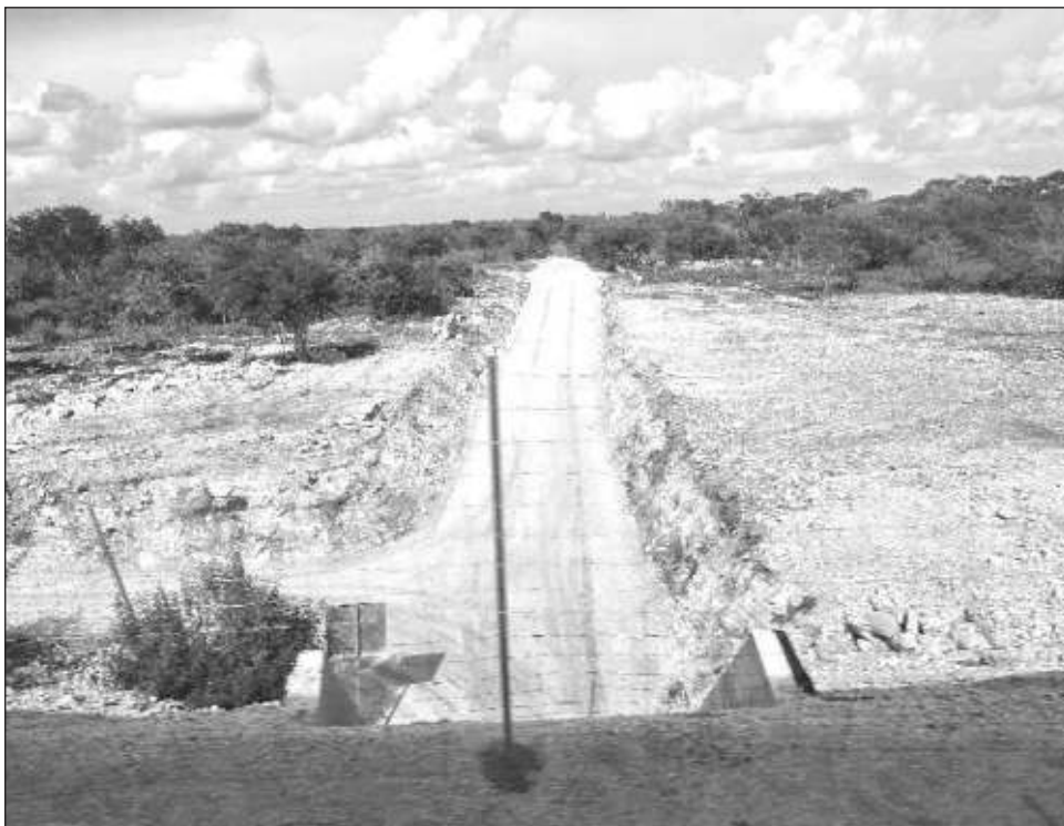
▲ Ambos predios fueron expropiados a favor de la empresa Fonatur Tren Maya, S.A. de C.V., para destinarlos a la construcción de obras de infraestructura ferroviaria. Foto Marco Peláez
