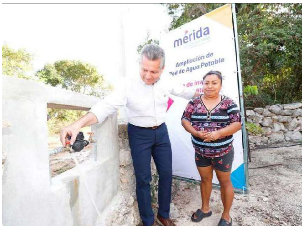
▲ "En Xmatkuil están por concluirse diversas acciones de vivienda, sistemas de riego, redes de agua potable y eléctrica, calles pavimentadas", detalló el edil. Foto ayuntamiento de Mérida
