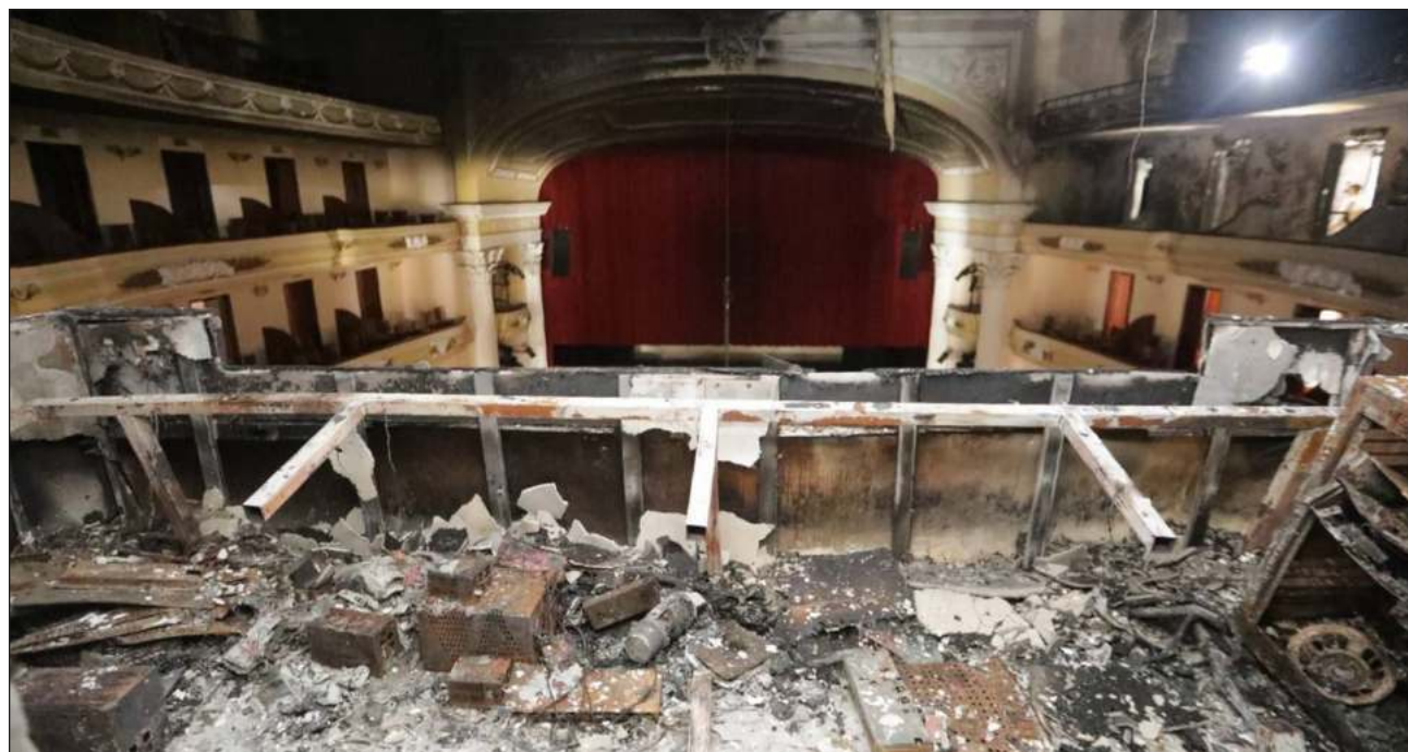
▲ Los mayores daños, tanto por el fuego como por el agua que emplearon los bomberos, se dieron en la cúpula central, el tercer nivel de plateas, donde está la cabina de audio, y algunas lámparas del teatro Peón Contreras.
