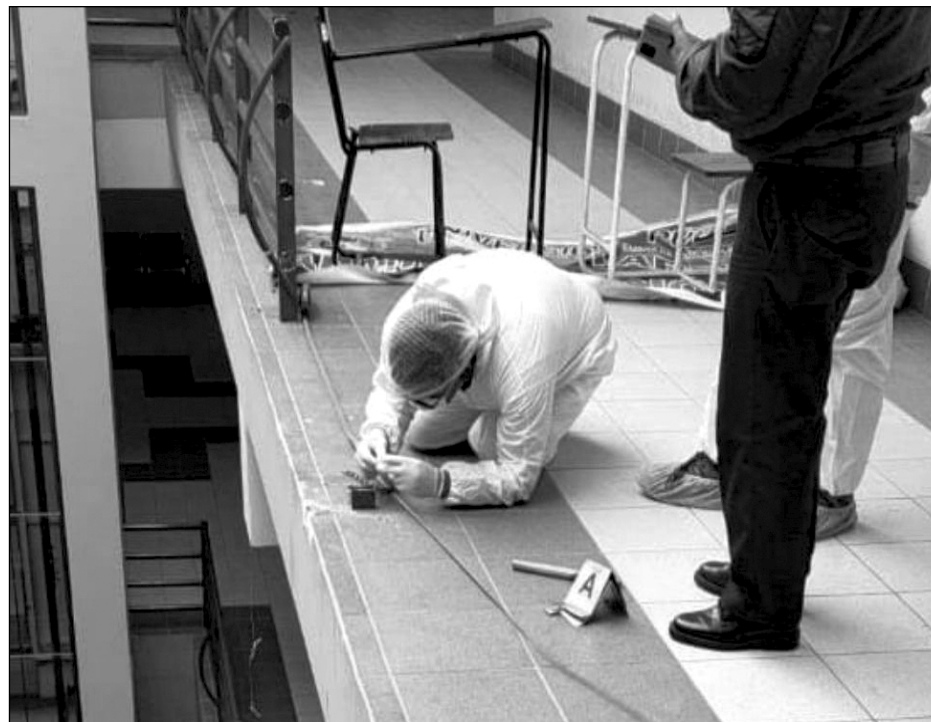
▲ El incidente ocurrió después de que se rompiera una barandilla en la UPEA. Foto FGE
