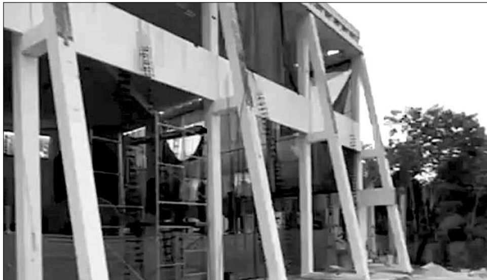
▲ Vecinos y ambientalistas denunciaron daño ambiental y construcciones irregulares por la cercanía con el Ombligo Verde , sin embargo, la obra no paró. Foto Ana Ramírez
