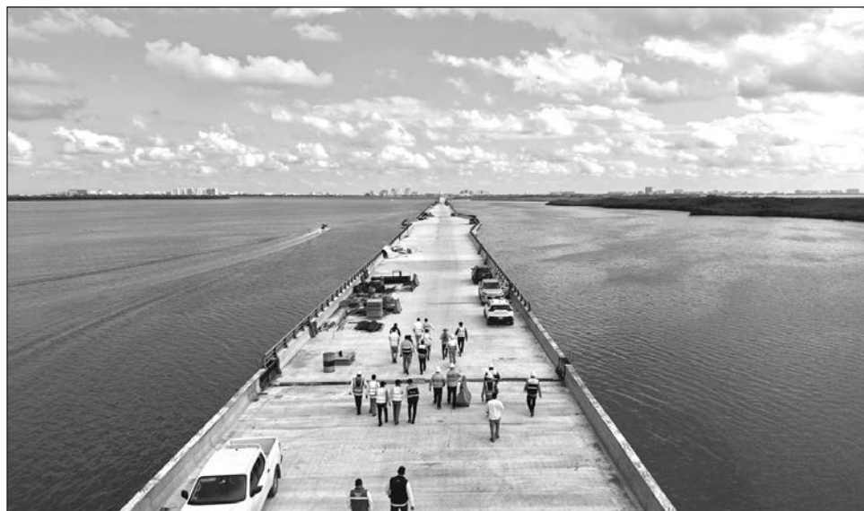
▲ Con una extensión de 11.2 kilómetros y un arco metálico de 103 metros de longitud, la obra transformará la movilidad en la zona y beneficiará a 1.3 millones de personas. Foto SICT
