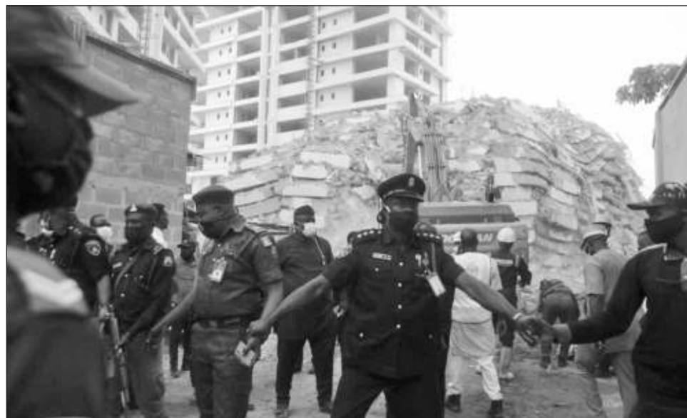
▲ Equipos de construcción esperaban que una excavadora llegara al sitio cuando el edificio repentinamente se vino abajo; hasta el momento hay tres personas muertas. Foto Ap
