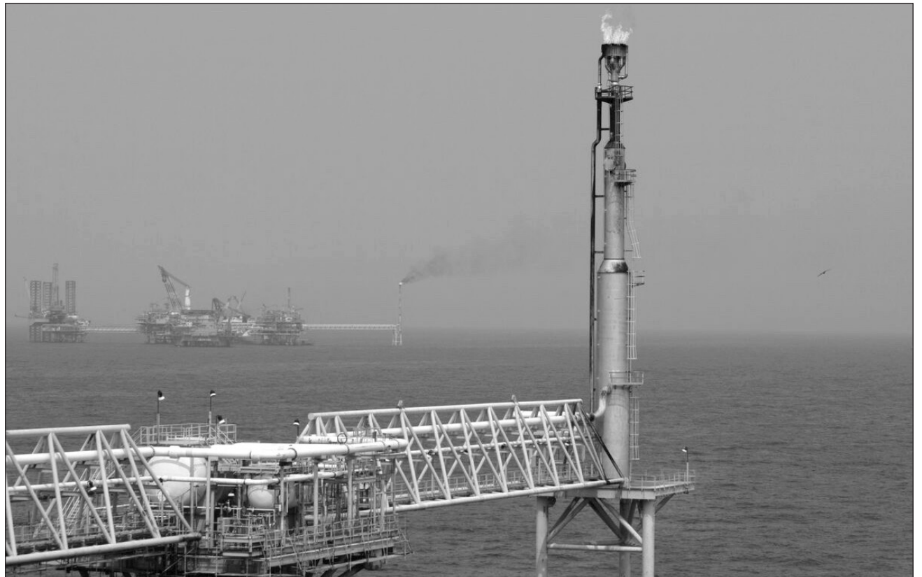
▲ Para evitar que el impacto fuera mayor, personal de mantenimiento operativo bloqueó el circuito afectado. Foto Reuters
