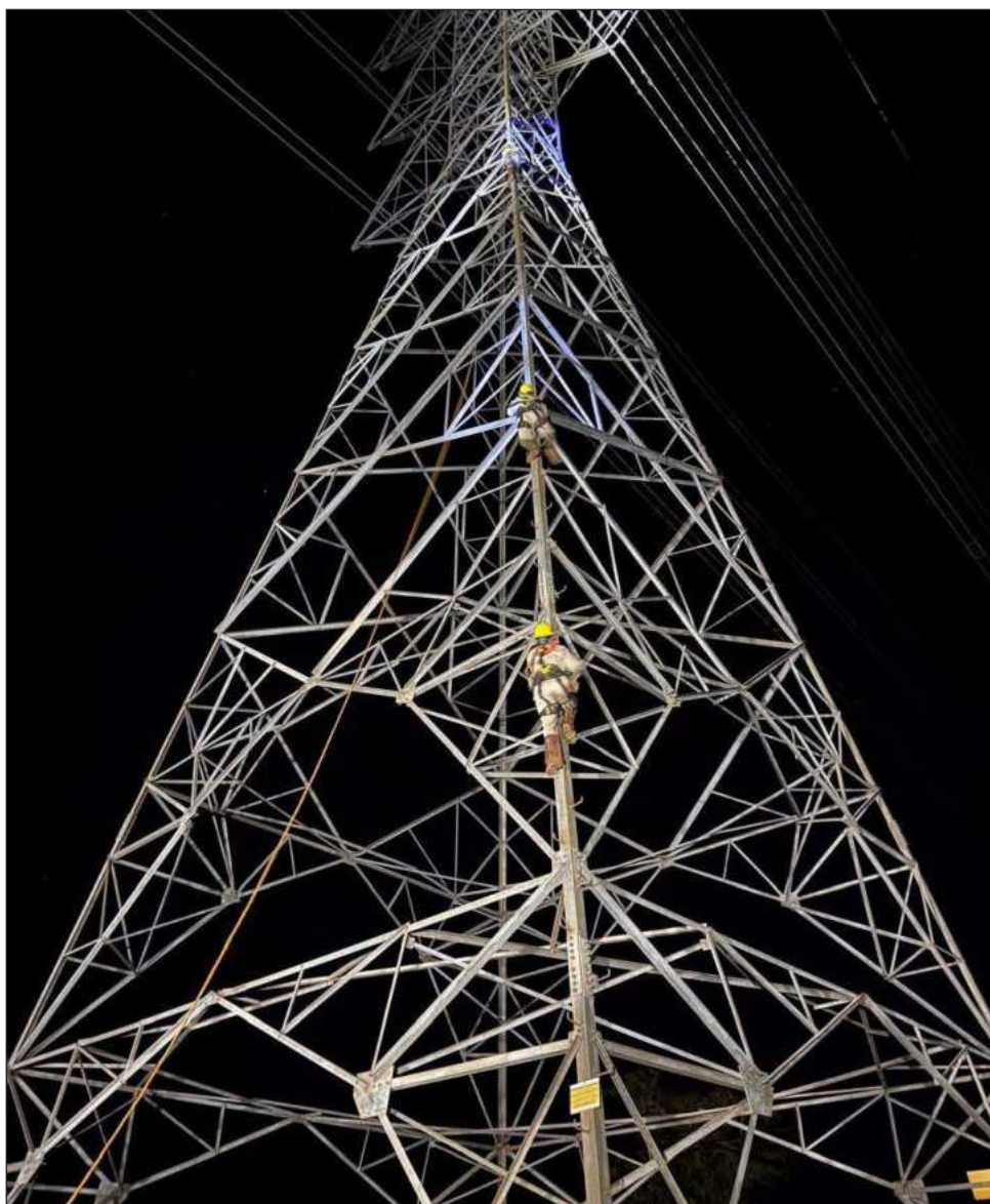
▲ El mandatario yucateco destacó que es necesario invertir en "mejorar las líneas de distribución y las líneas de transmisión que ya están obsoletas y necesitan una gran inversión por parte de Comisión Federal de Electricidad". Foto CFE
