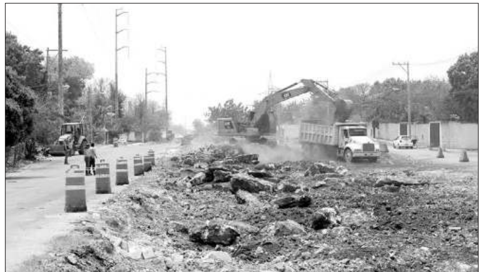
▲ El gobernador recorrió las obras que consisten en el mejoramiento de la infraestructura vial, civil y eléctrica en 10 kilómetros que van del Gran Parque La Plancha hasta la calle 108. Foto gobierno de Yucatán
