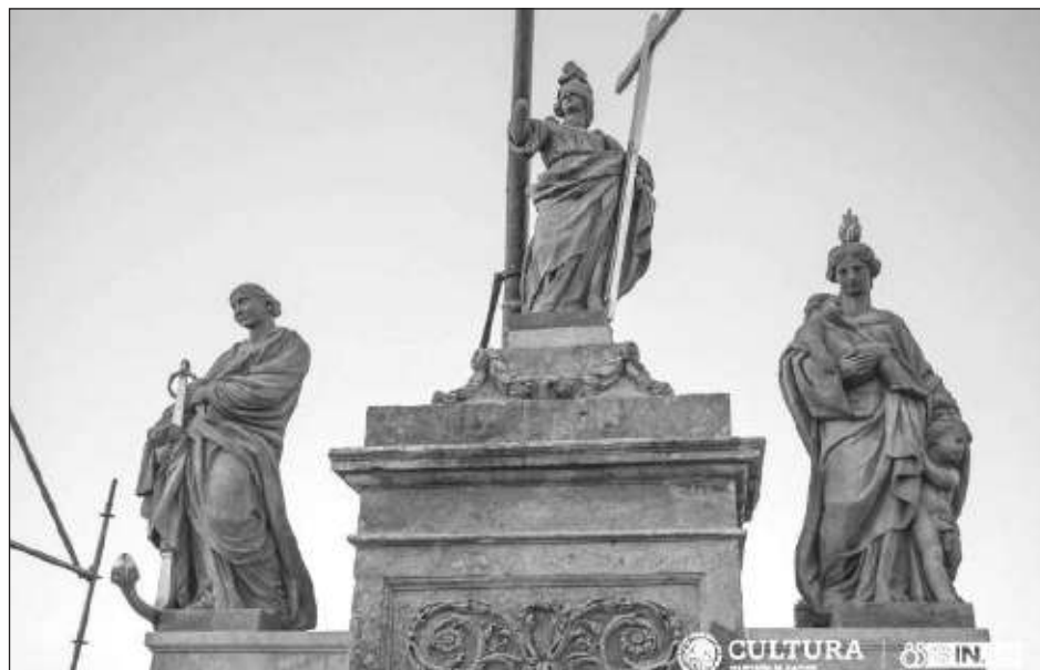
▲ La Fe, la Caridad y la Esperanza, que regresan a su lugar luego de su restauración, debido a que sufrieron daños severos por el sismo del 19 de septiembre de 2017. Foto INAH
