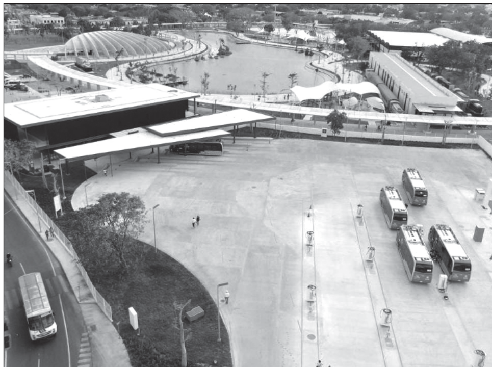
▲ Las instalaciones fueron dotadas de aire acondicionado, iluminación de led y de huellas podotáctil de cerámica en piso; muros cargadores, muebles sanitarios, así como la instalación de un sistema de circuito cerrado de televisión con cámaras de seguridad. Foto gobierno de Yucatán
