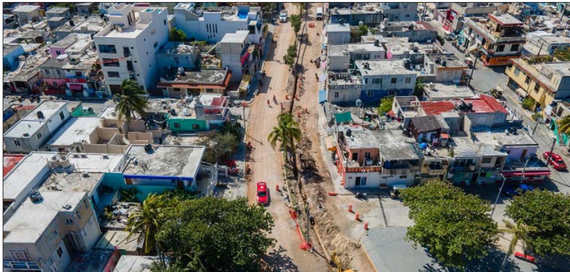
▲ El proyecto, que se desarrollará en un periodo de septiembre de 2025 a marzo de 2026, contempla la instalación de más de 18 mil 400 metros de tubería nueva, así como la rehabilitación de 2 mil 155 tomas domiciliarias. Foto Aguakan
