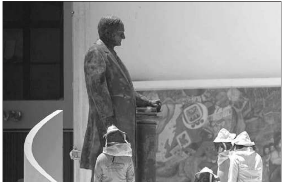
▲ El 28 de mayo del presente año inició la reubicación del asta bandera y de la estatua a Andrés Quintana Roo, “en los próximos días continuarán los trabajos preliminares”. Foto Congreso de Quintana Roo
