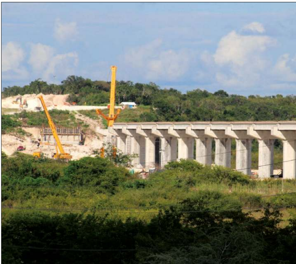
▲ El presidente Andrés Manuel López Obrador reveló que 70 por ciento del tramo Cancún-Tulum será “como un viaducto de concreto”, para librar los ríos subterráneos. La imagen corresponde a la construcción del paso elevado del tren que cruzará el libramiento de la ciudad de Campeche para tomar la ruta del Camino Real hacia Mérida. Foto Fernando Eloy
