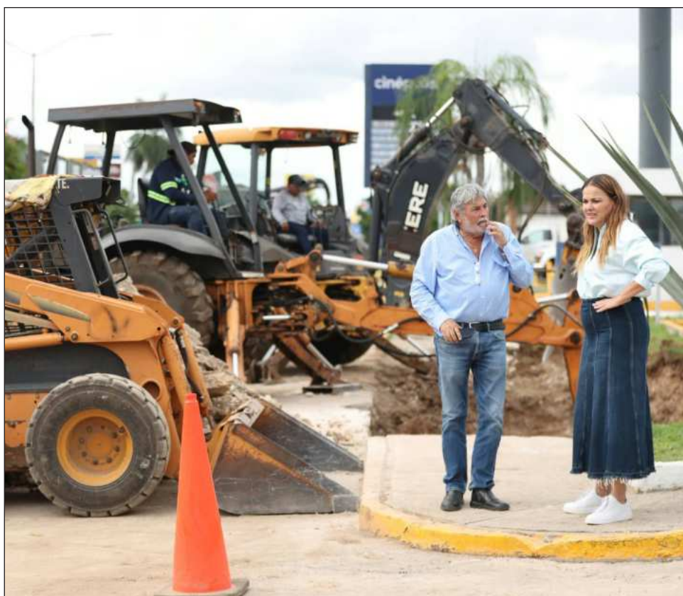
▲ Cecilia Patrón supervisa trabajos de bacheo en la colonia Miguel Hidalgo Ciudad Cauce, como parte de las acciones para mejorar los servicios públicos. Foto Ayuntamiento de Mérida.
