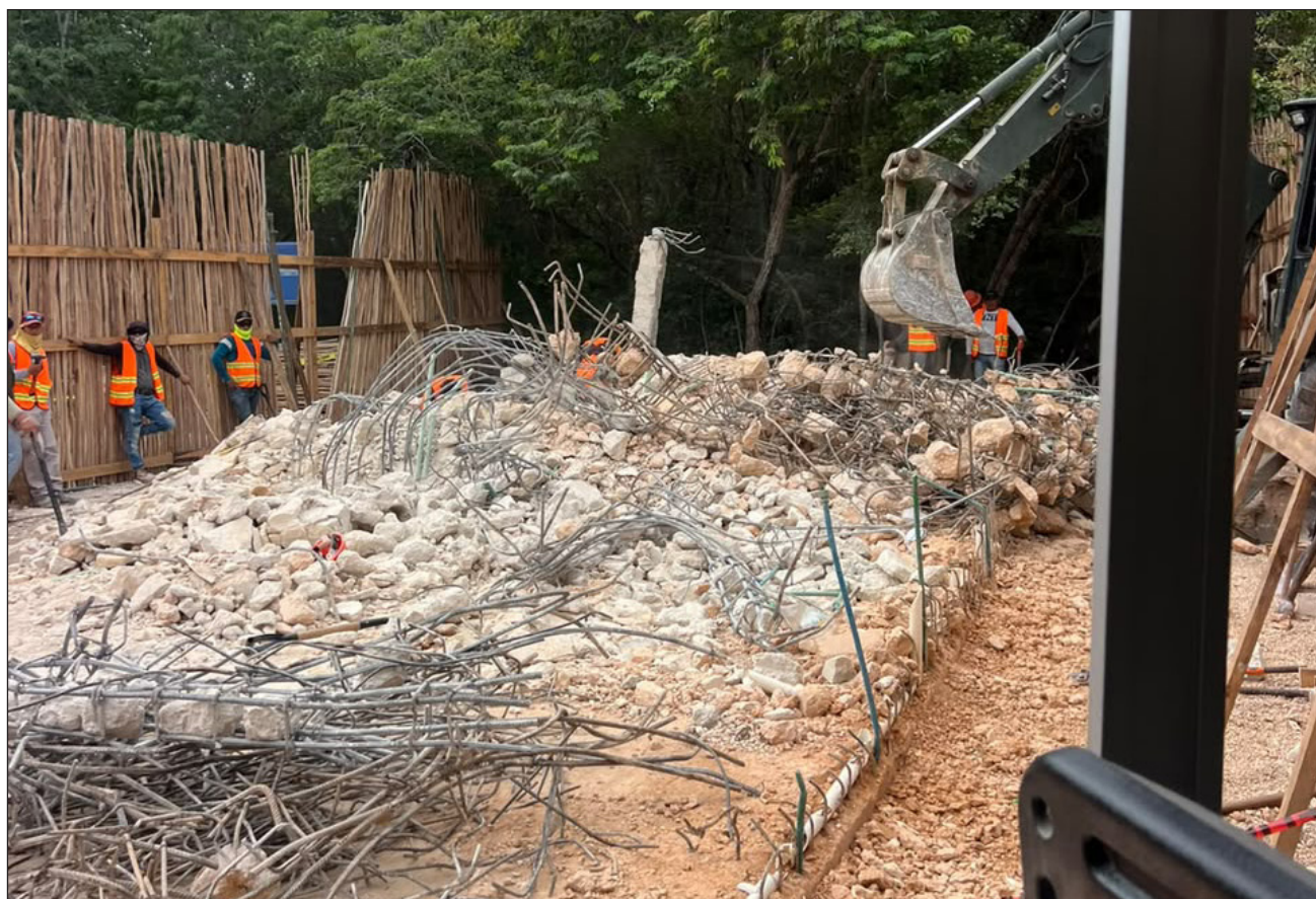
▲ Con la demolición se busca dar paso a un corredor turístico en esta tradicional entrada al sitio arqueológico, al tiempo que se retoma la movilización de visitantes desde la zona comercial hasta el acceso a las ruinas. Foto Miguel Améndola
