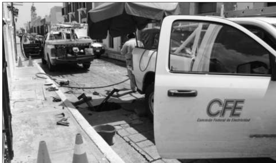
▲ El Comité de Protección Civil detectó al menos 40 registros dañados de la CFE, los cuales requieren intervención de la paraestatal para seguridad de la población. Foto Fernando Eloy
