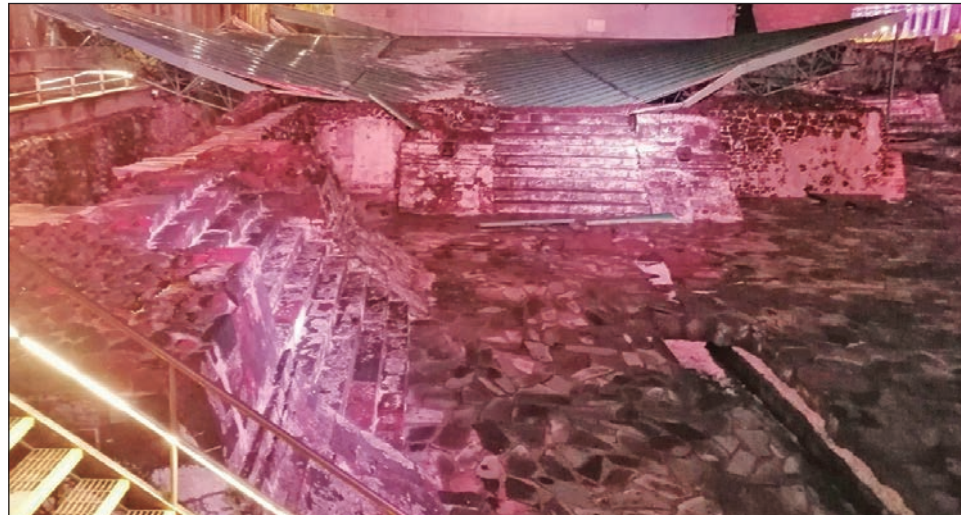
▲ Los daños reportados fueron en las estructuras de techumbre y barda perimetral. Foto @LeoLopezLujan
